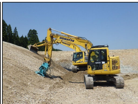
図-3 法面部転圧状況
