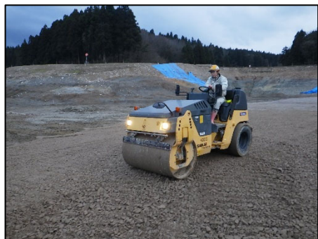
図-2 池敷部転圧状況
