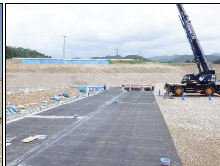
図-4 遮水シート敷設状況
