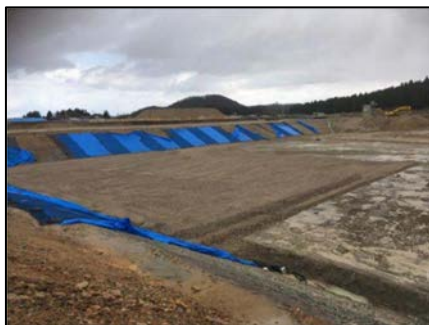
図-5 池敷設部盛立完了
