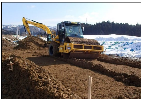
図-2 簡易締固め試験
