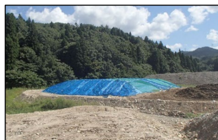
図-9 雨対策養生状況
