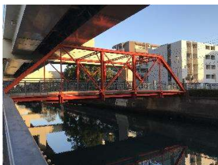
鋼製トラス橋
