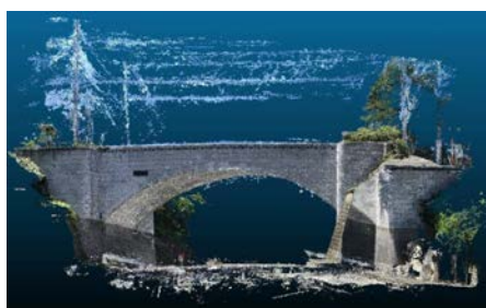
f) コンクリート橋外れ点除去
