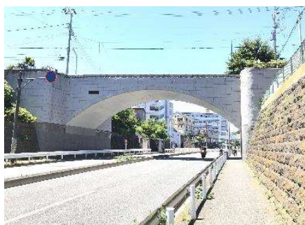
コンクリート橋
