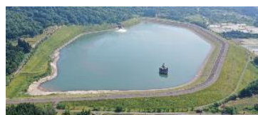
図-1 検証対象ダム
