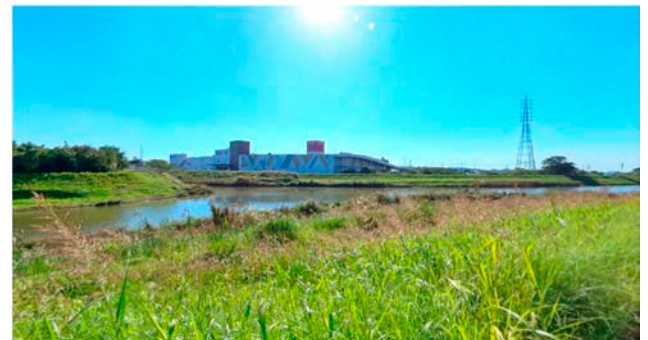
図-2 現況写真(360°写真から作成)
