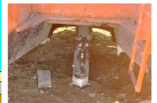
写真-2 沈下板圧入前
