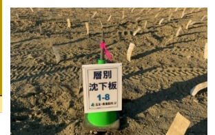
写真-3 沈下板圧入完了
