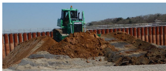
写真-1 スtockパイル切崩し状況
