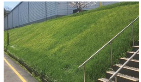
写真-1 マルチ法面工法
