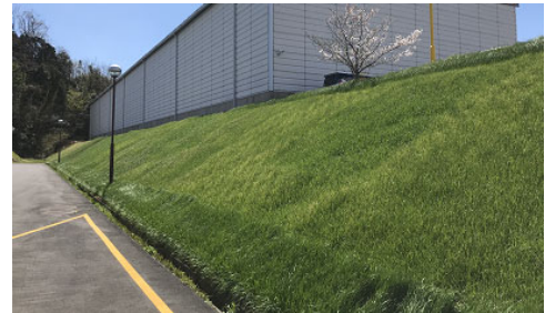
写真 1 複合型法面工法
