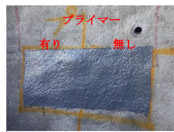
写真8 防水材吹付後
