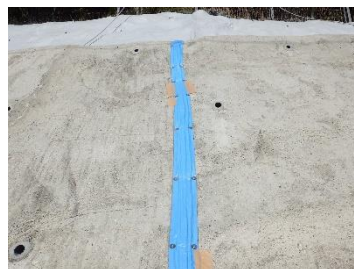
写真 4 排水ドレーン設置状況
