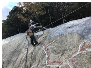
写真 2 吹付施工状況
