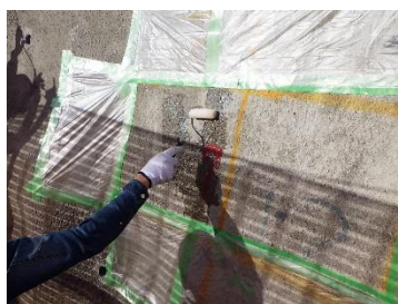
写真6 プライマー塗布状況
