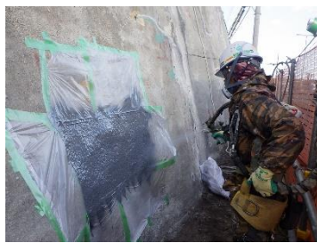
写真7 防水材吹付状況
