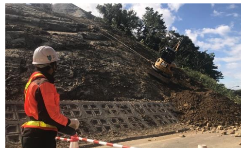
写真5 セーフティークライマー工法
