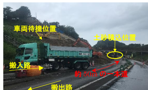
写真6 トレーラダンプの採用
