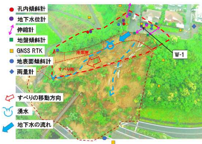
図-4 動態観測設置状況
