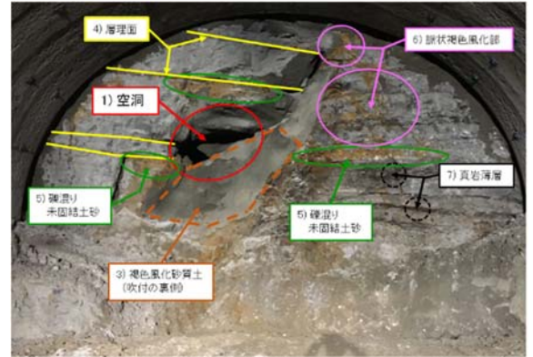
写真-1 切羽全景
