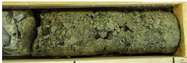
図-1 コアA コンクリート直下（0.85～1.00m 付近）
