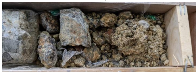
図-2 コアB コンクリート直下（0.88～1.00m 付近）
