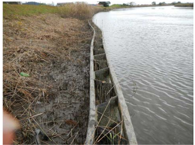
写真3 浜戸川①における堤外側の矢板の頭部
