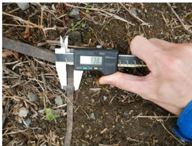
写真 2 白川①における堤内側の矢板の頭部
