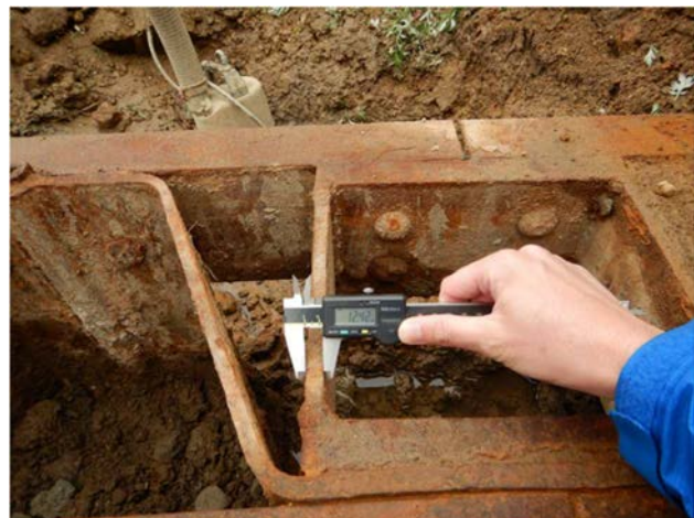
写真5 緑川①における堤内側の矢板の頭部
