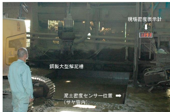
写真2：常設プラントの設置された大型表示計
