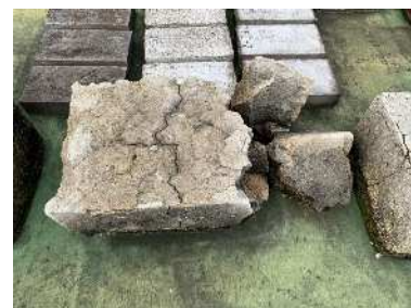
写真-1 曝露養生を行った気泡混合軽量土
