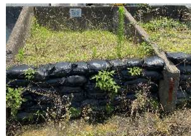
写真-2 土中養生を行った気泡混合軽量土
