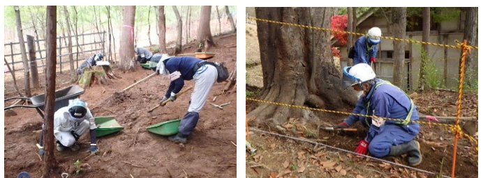
図-3 強残渣の除去 作業状況 (左：人力での除去、右：根圏周辺の除去)
