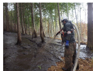
図-4 吹付け状況
