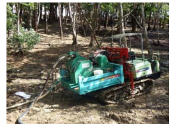
図-6 中継ポンプ
