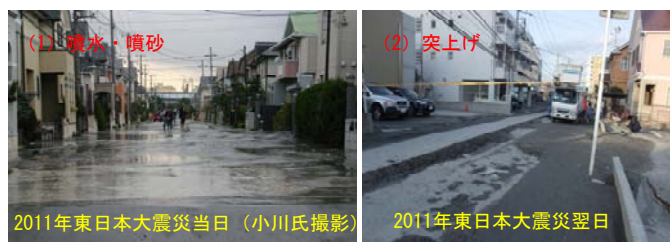
写真1 噴水・噴砂、突上げの事例
