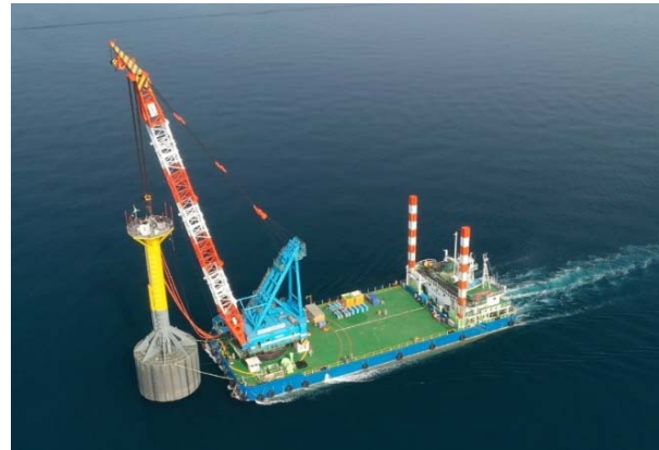
Photo 1 試験体実海域曳航状況
