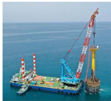
Photo 6 完全撤去状況
