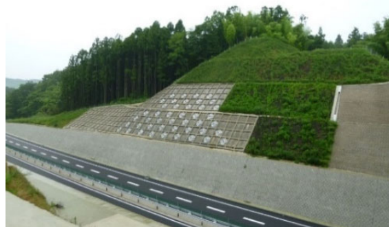
図-1 対象切土のり面全景
