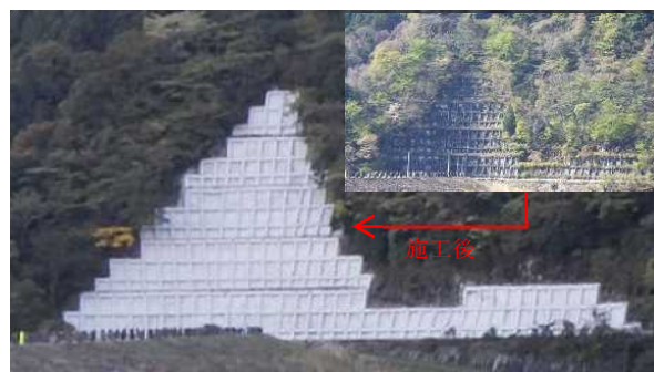
写真 4 施工前後全景比較写真
