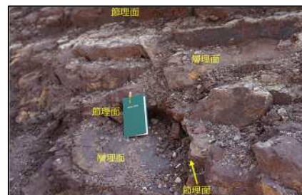
図-2 法面の分離面（層理面および節理面）の状況
