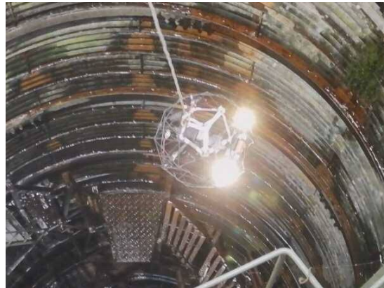
写真-1 ドローンによる点検状況
