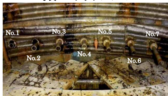
写真-4 水抜きボーリング孔（下段）
