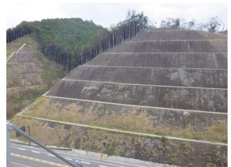
写真-1 再施工前(2018年11月) 既存の植生基材吹付工の植生が衰退
