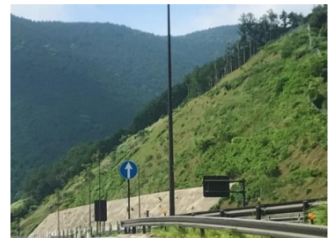
写真-2 再施工2年4カ月後(2021年7月) 熟成調整・保水材により植生状態が良好
