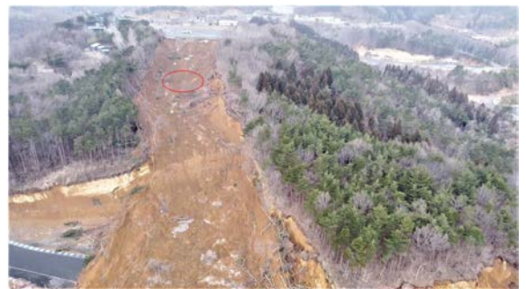
写真-1 斜面崩壊状況 1) と試料採取位置
