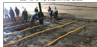
写真2-コンクリート打設状況①
