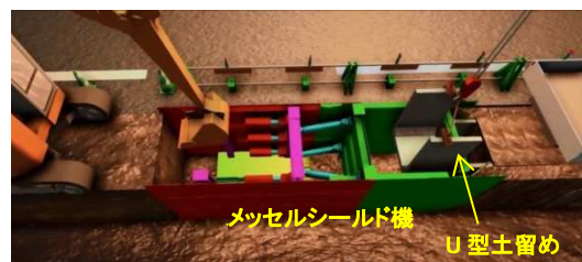
図-2 急速化工法の概要
