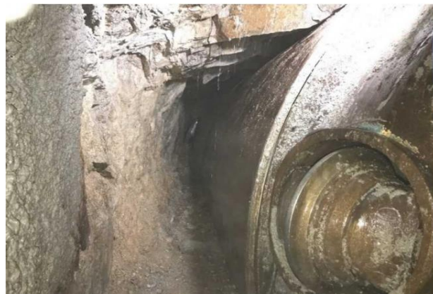
図4 右側面堆積土砂の除去（切羽より撮影）
