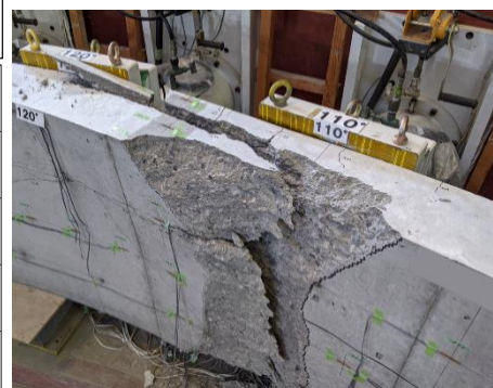
写真-1 肩部の損傷状況 (case2)
