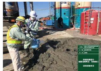
写真-1 未固結試料採取状況
