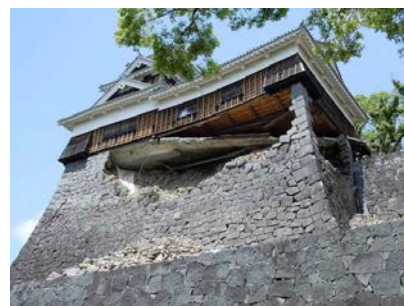
写真-1 崩落後の南面石垣
