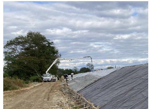
図-1 透気防水シート上に敷設中の布製型枠
