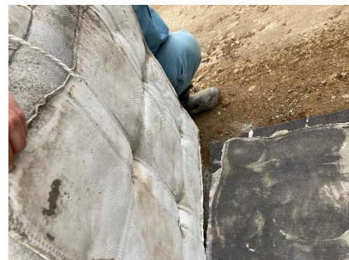
図-6 コンクリート注入硬化後の布製型枠底面
