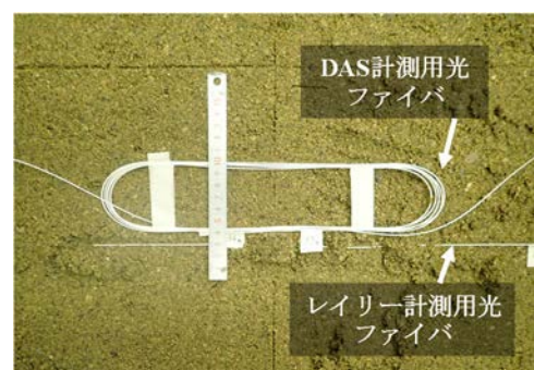
図-1 光ファイバ埋設状況
