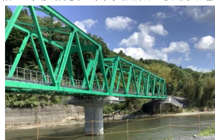
図1 検討対象橋脚の全景
