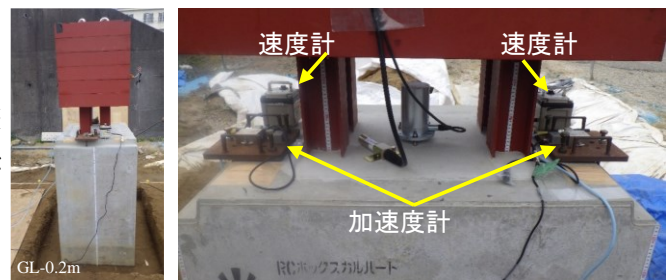
図2 掘削状況の例とセンサ設置状況(橋脚天端)
