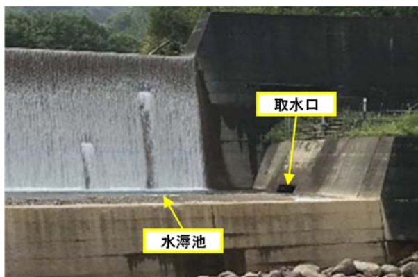
図-1 砂防堰堤施設状況
