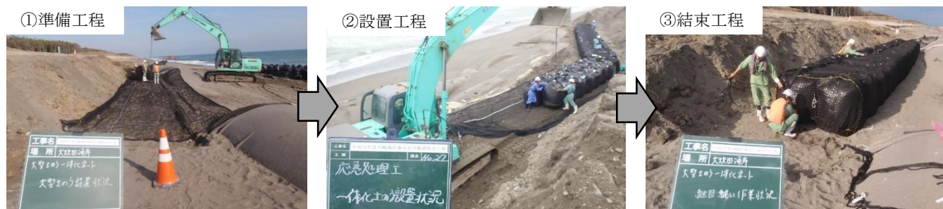
写真-3. 応急対策工法の施工方法
