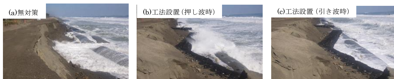
写真-4. 波浪の作用状況：(a)無対策箇所、(b)(c)工法設置箇所
