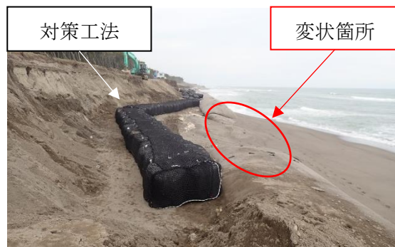
写真-2. 応急対策工法の施工状況
