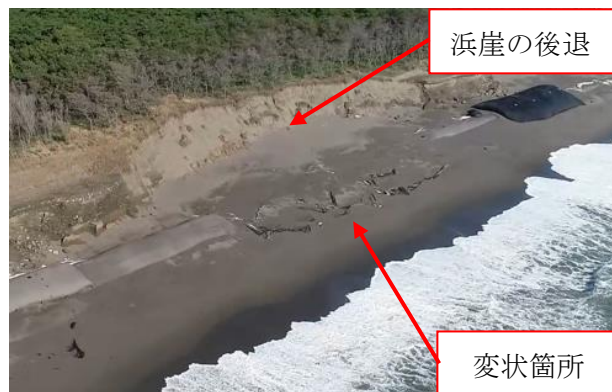
写真-1. サンドバック変状箇所の浜崖後退
