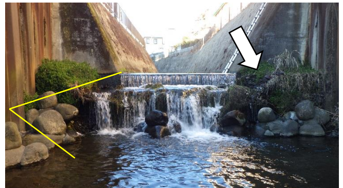
写真-1 簡易的な水路式魚道の設置イメージ
