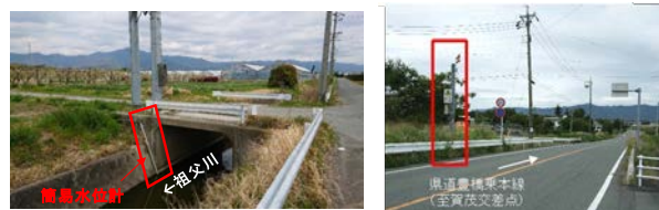
図-3 簡易水位計・CCTV・回転灯設置状況
