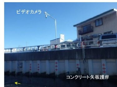
写真-1 ビデオカメラ設置状況
