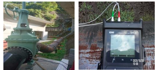
図4 仮設管敷設・流量管理
