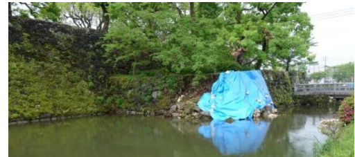
(b) 松江城址の城壁 (八代市) 図1 2016年熊本地震での被害
