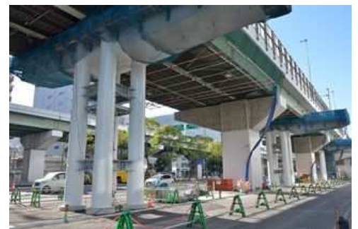
写真-1 鋼管集成橋脚 (西船場 JCT)
