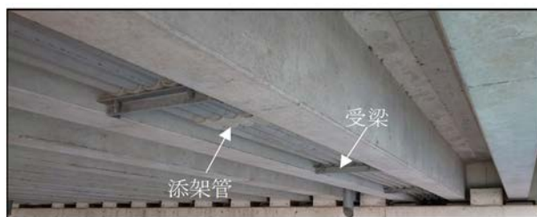
図1 添架管と受梁の写真、左は橋梁A、右は橋梁B
