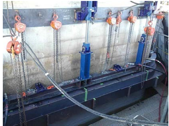
写真-3 鋼板圧入状況
