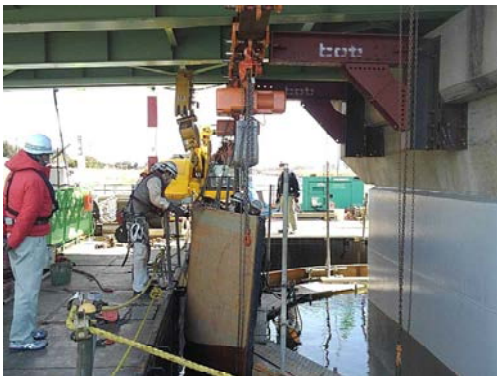
写真-2 簡易仮締切施工状況
