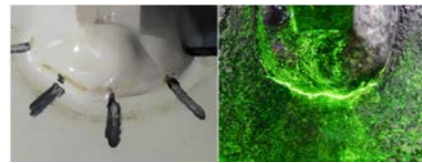
図1-1 溶接継手部の疲労き裂
