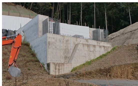
写真-1 現状の橋台
