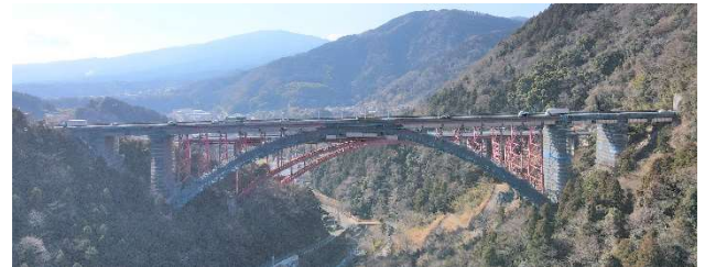
写真-1 全景 (足場が設置されている手前が本橋)
