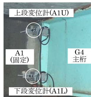
図-3 A1 変位計設置状況
